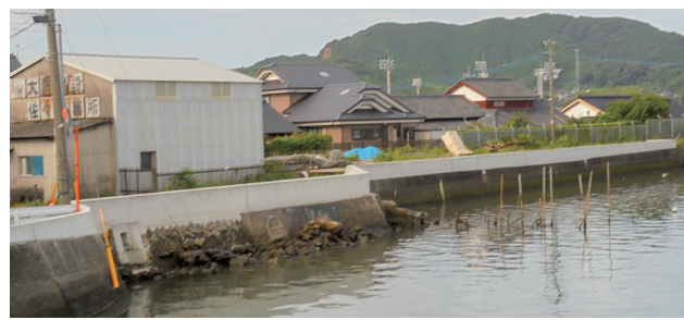
完成した四ツ井樋地区の堤防
