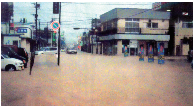
平成14年の冠水状況
