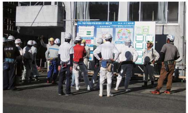
安全面と工程の説明を受ける現場作業員
