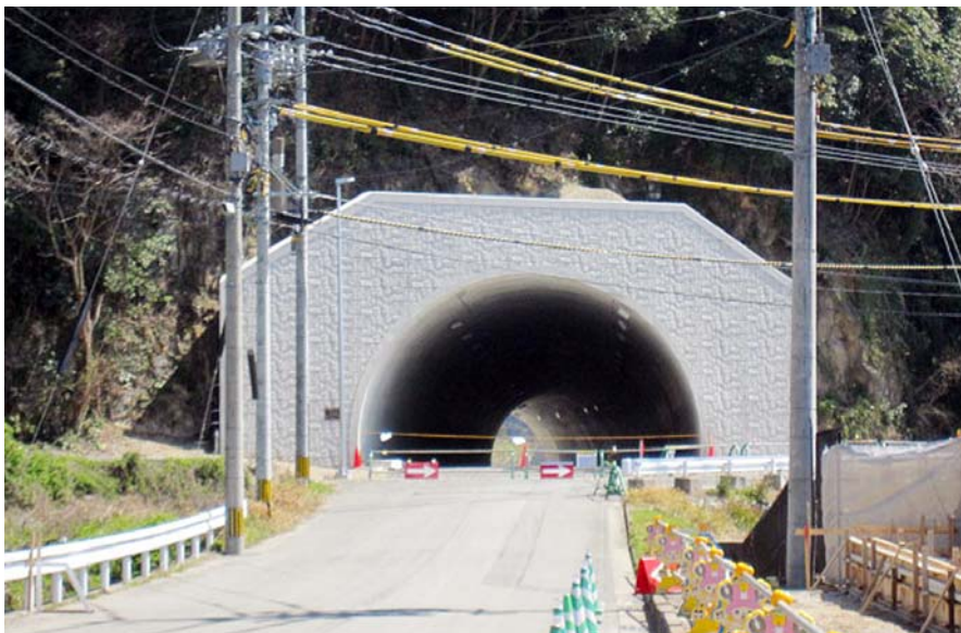
棚方崎真申線のトンネル工事
