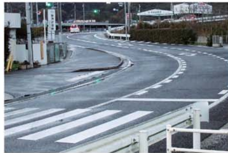
四ツ井桶踏切前横断歩道
