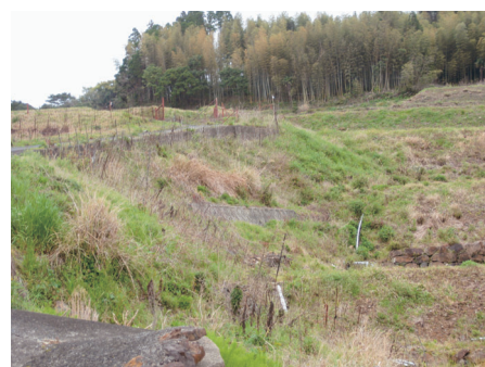
ガードレール設置が必要な片木線
