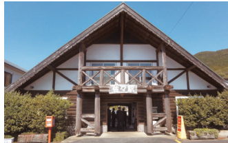
改修工事予定の MR 佐々駅 (観光情報センターを移転)
