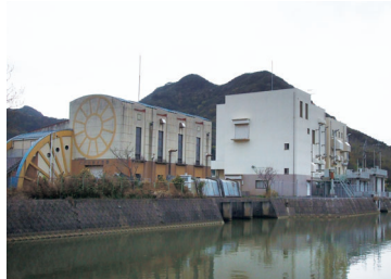
大新田排水機場補修事業
