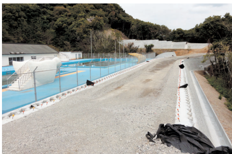
町民プール横の中央配水池道路整備
