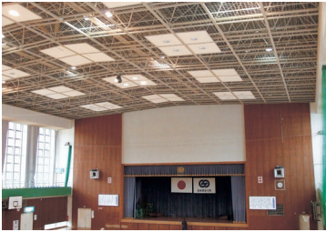
町民体育館天井等改修事業
