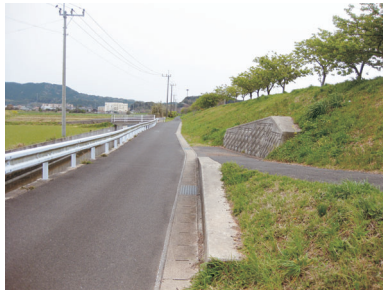
桜堤法面にも河津桜の植栽を
