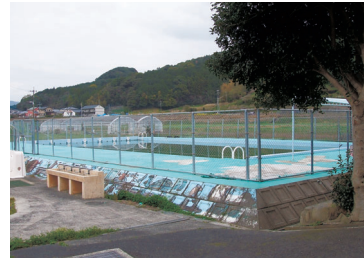
佐々小学校プール改修事業
