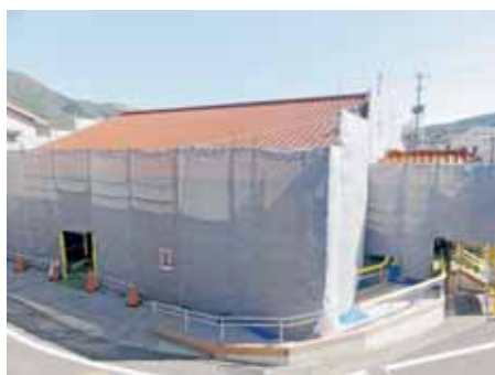
補修工事（集会所外壁塗装）
