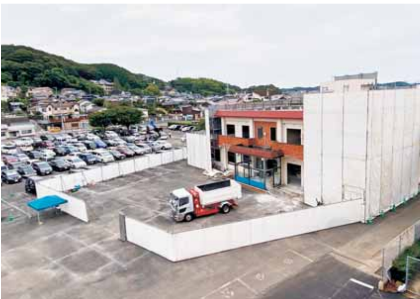
庁舎建設に向けて別館の解体はじまる
