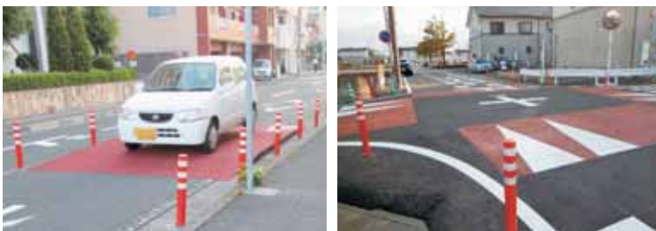
ハンブ (高さ10 cm程度・長さ2~3 Mのこぶ) 時速30 km制限の道路に有効。
