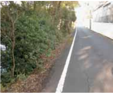
2年間放置されている危険箇所のガードレール設置
