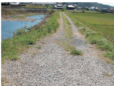
佐々川沿い道路の早期舗装を
