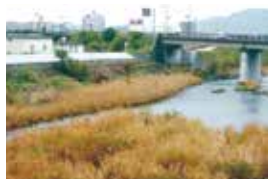
国道下の状況
