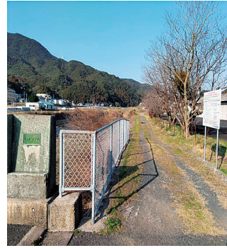
北部未舗装区間
