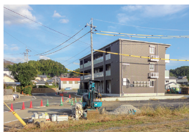
建設中の社員寮
