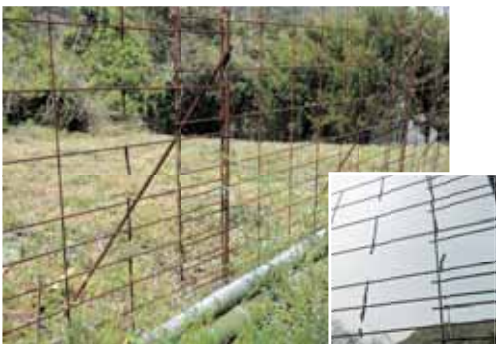
大茂地区ワイヤーメッシュの腐食
