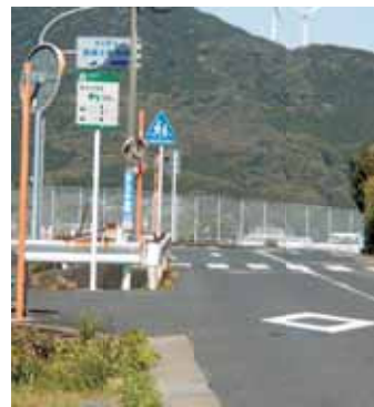
歩道未整備箇所
