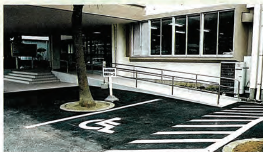
公民館玄関をスロープに
