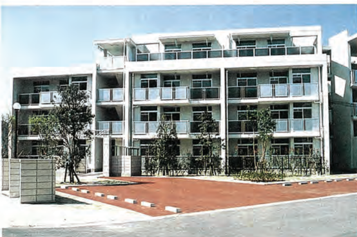
▲36戸の入居が始まった口石団地
