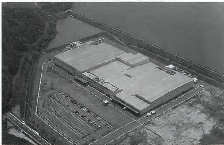
▲操業を開始したアリアケジャパン (株) 九州第2工場を空から撮影 (資料提供 アリアケジャパン (株))
