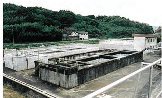
▲完成した沈澱池及びろ過施設（増設分）
