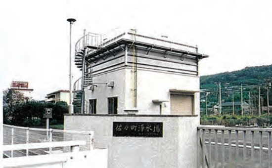
▲完成した薬品貯蔵室（下部）及び原水槽（上部）
