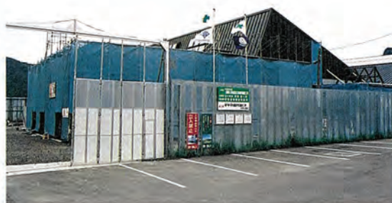
▲建設中の町立診療所（総合福祉センター）
