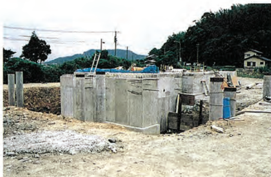
▲建設中の志方地区農業集落排水処理施設
