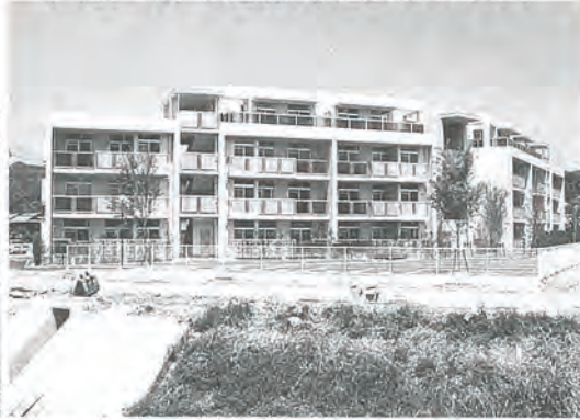
▼平成9年4月に22戸の入居が始まった口石団地 本年度 36戸の建設が予定されています。
