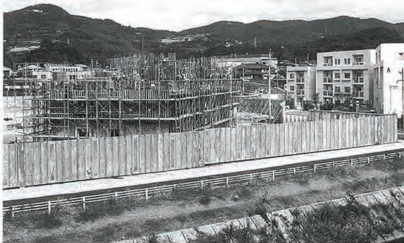
▶現在建設中の口石団地（2期工事）
