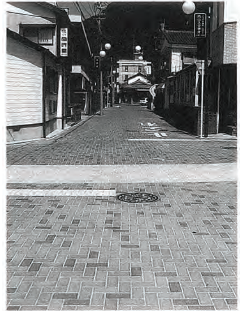
中部地区まちづくり事業（カラー舗装）
