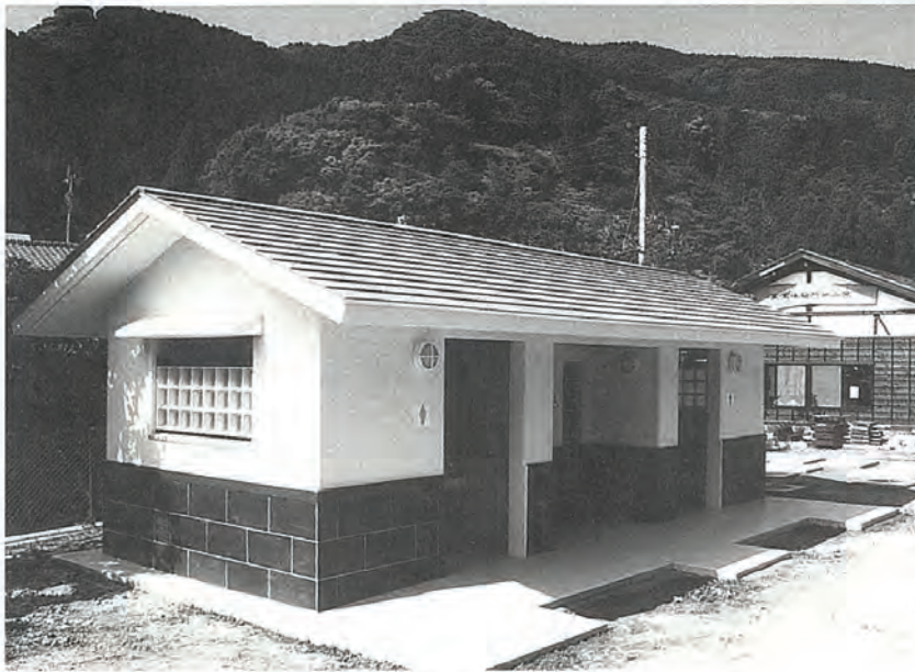
新しくなった野外便所
