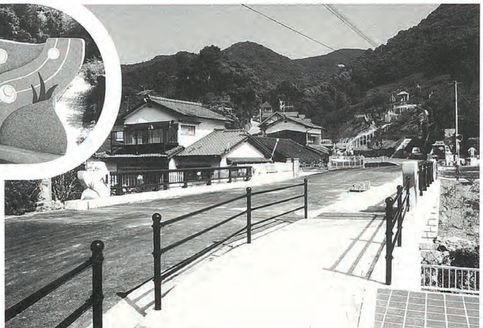
拡幅された道路と ▶ 架け替えられた平野橋
