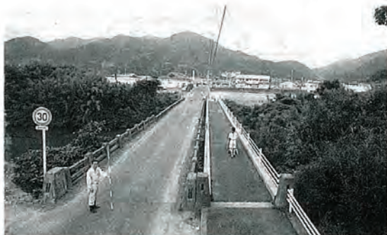
完成した 正興寺橋
