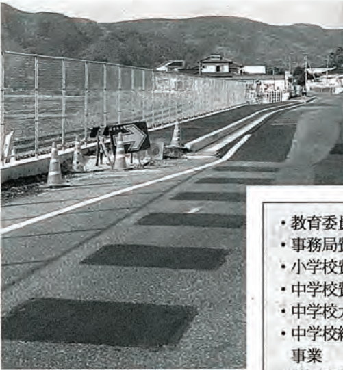
継続して整備が進められる町道神田線歩道
