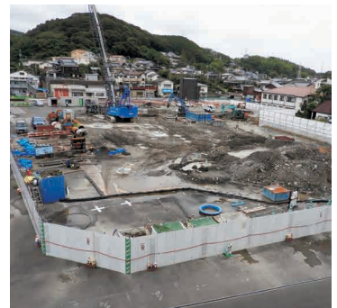
新庁舎建設の様子
