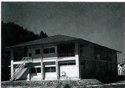
末永団地横に建設された南部地区体育館
