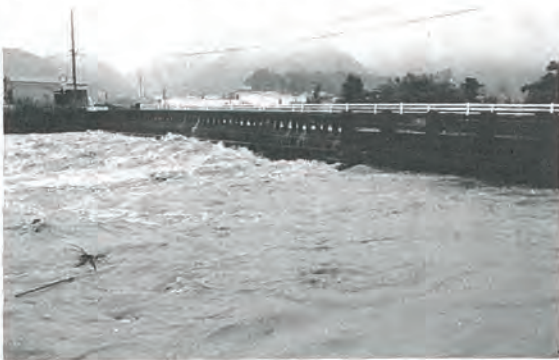
濁流が打ちつける神田正興寺橋
