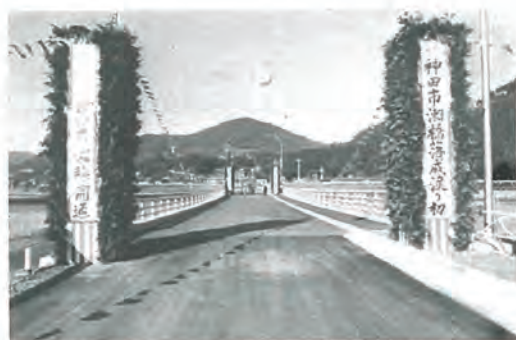
完成した町道神田市瀬線
