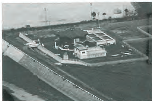
完成した浄水場全景
