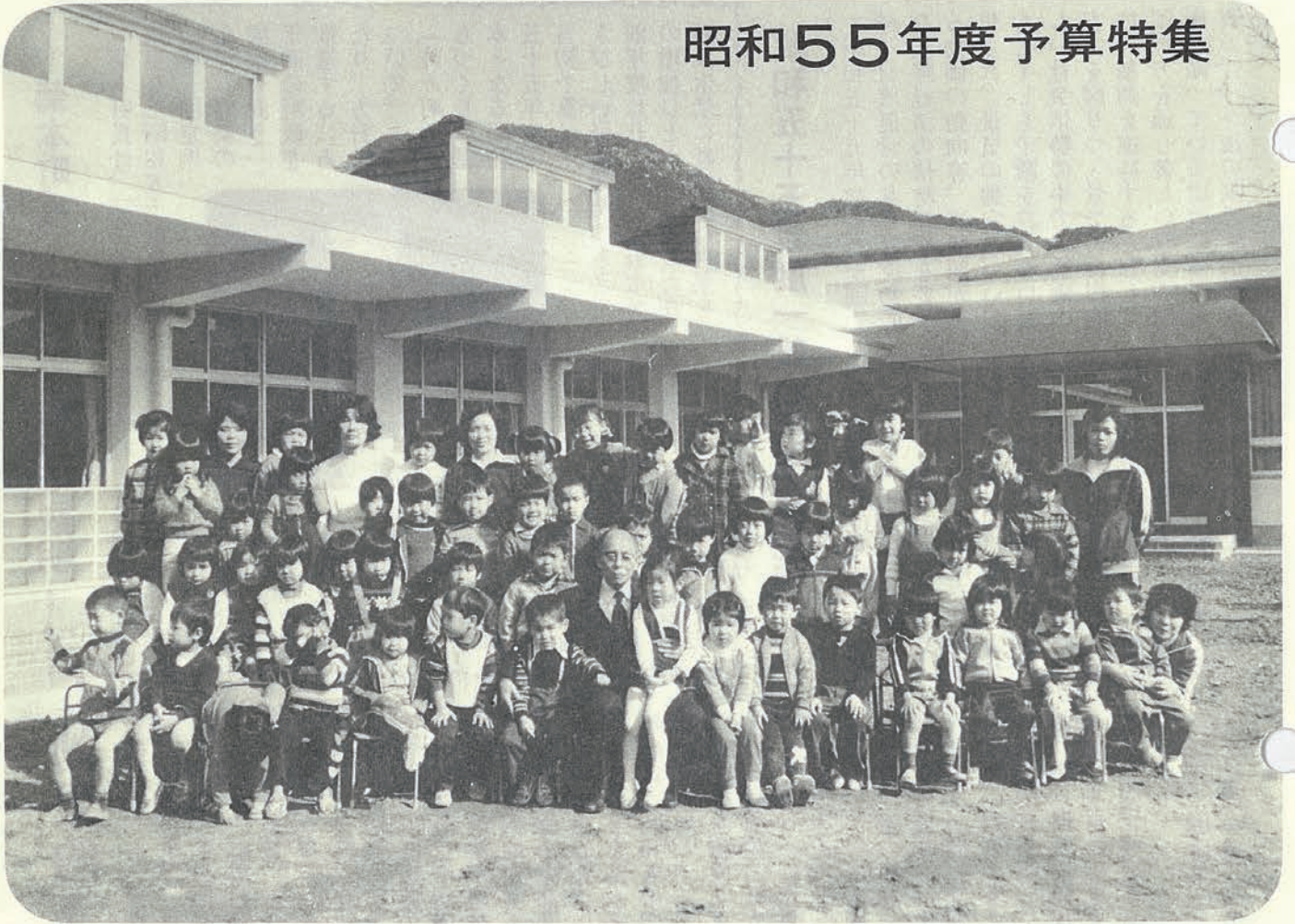
(完成した第3保育所)
