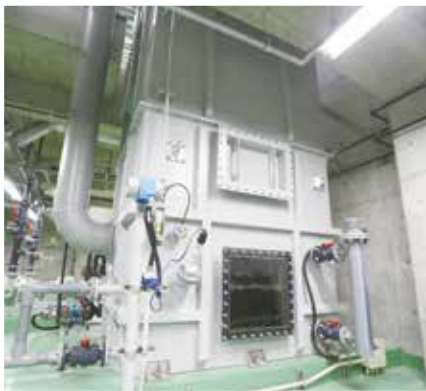
生物脱臭塔(地階) 微生物により臭気成分を取り除きます。
