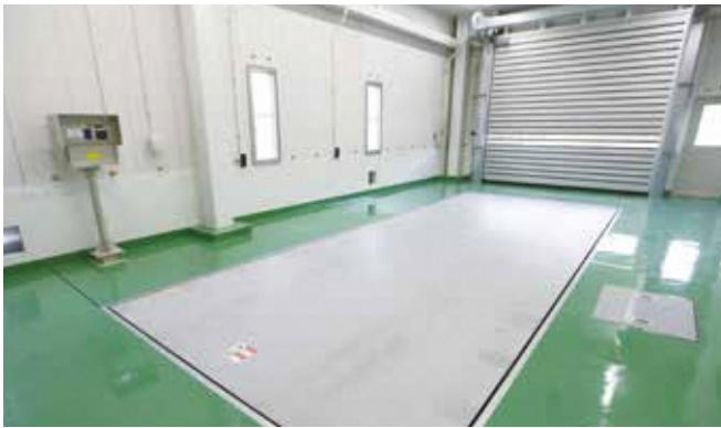
トラックスケール(1階) し尿・浄化槽汚泥の重量を計測します。
