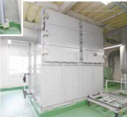
活性炭吸着装置 (2階) 活性炭により臭気成分を吸着し、空气中に放出します。
