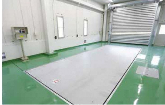
トラックスケール(1階) し尿・浄化槽汚泥の重さをはかります。
