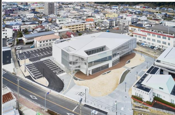
【新庁舎建設工事の状況】
