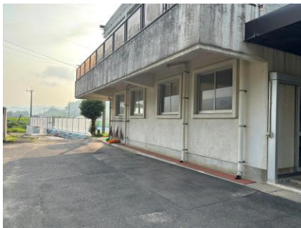
（佐々小学校 撤去後の玄関手洗い場）
