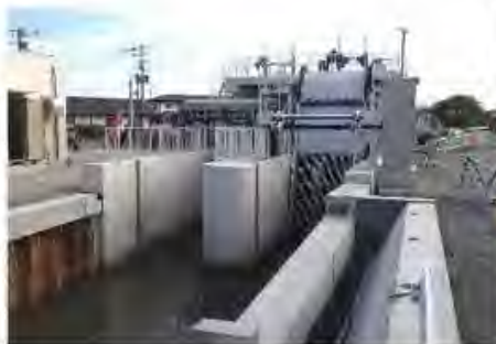
雨水ポンプ場の整備
