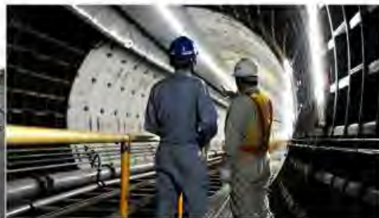
雨水貯留管の整備
